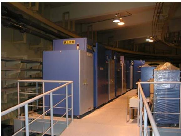
図 25 キッカー電源パルサー部
