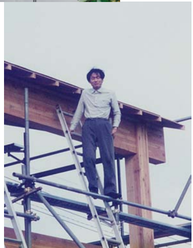
自宅建築現場
