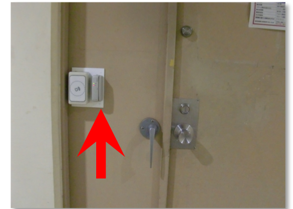
宅配荷物室扉
