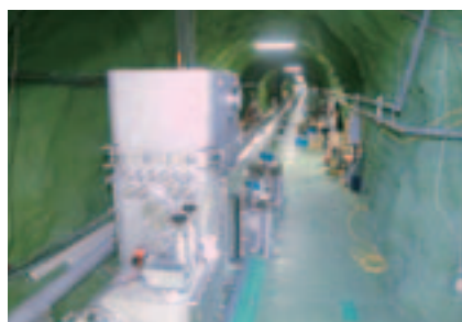
神岡に設置されている重力波望遠鏡のプロトタイプ (CLIO)。鏡を冷やす冷凍機システム（写真、手前）に技術貢献しています。
