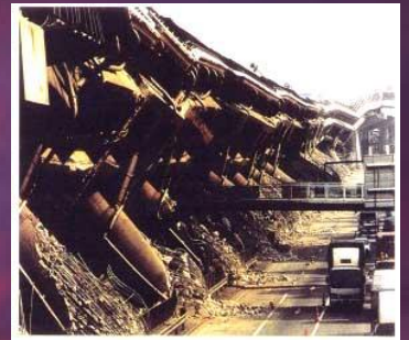
図7-15 兵庫県南部地震により倒壊した阪神高速神戸区 【毎日新聞社 提供】
