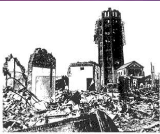
図5-12 関東地震による被害状況(東京都台東区浅草) 【毎日新聞社 提供】
