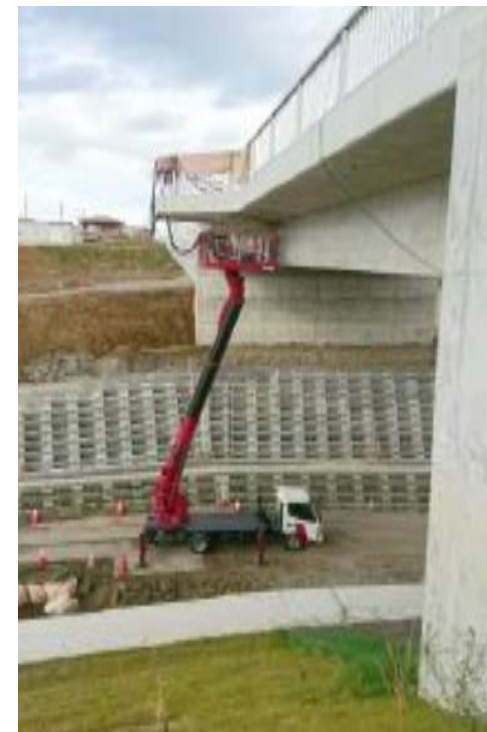
橋梁・インフラ検査
