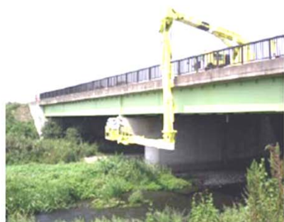
橋梁点検車を使った 橋梁点検
