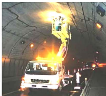
近接目視による トンネル点検
