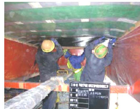
炭素繊維シートによる補修
