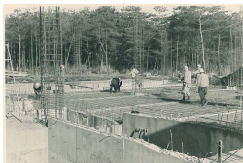
1971年 コントロール室基礎工事
