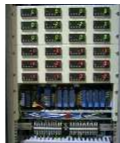
インターロックシステム
