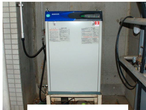
写真3：交換後のベビコン
