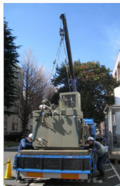
図 15. 搬出される液化機
