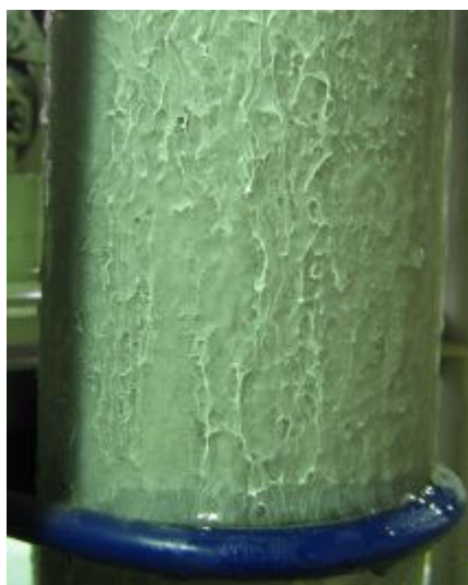
V806 操作前：結露が凍っている
