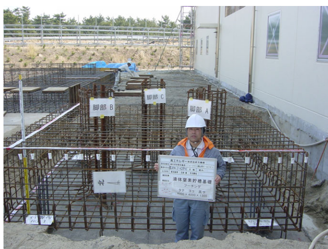
Fig. 4 液体窒素貯槽基礎配筋検査
