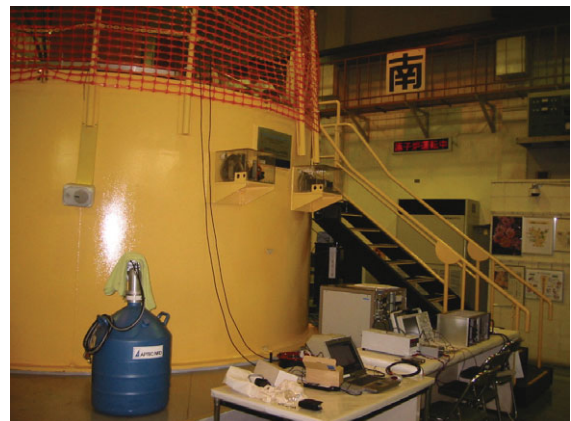
図 3. 近畿大学原子炉 (UTR-KINKI) の右下机には各種計測機器が配置される
