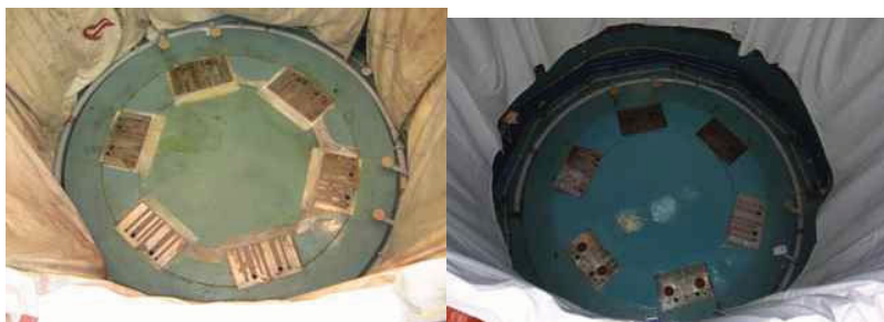
図6. MG基礎部清掃前（左）、清掃及び塗装後（右）
