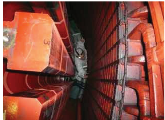
図4. 発電機固定子楔打音試験中
