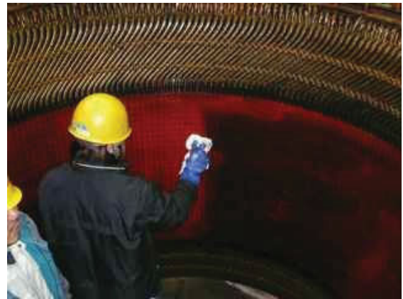
図3. 8.5MW 起動用誘導電動機固定子内部
