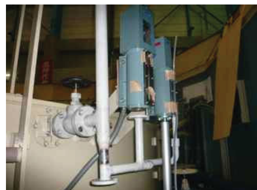
図5. 油面計位置調整作業中
