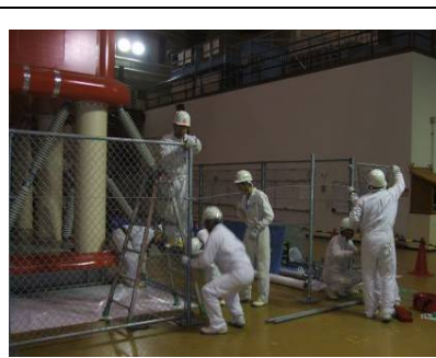
写真 4 HVT 安全柵撤去
