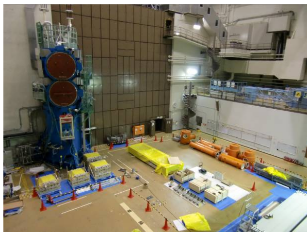
写真 27 撤去後の組立室
