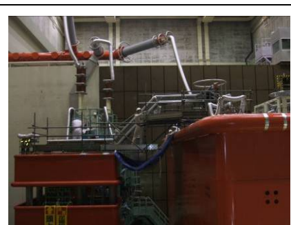
写真 5 HVT4F ケーブルトレイ撤去
