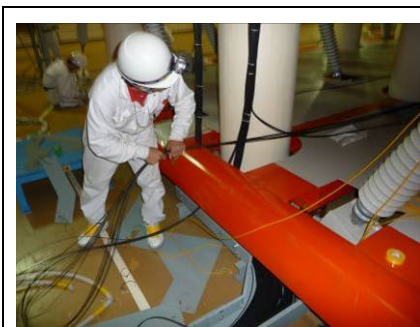
写真 3 計測線等の撤去
