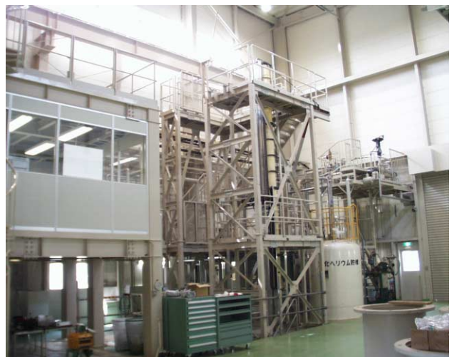
第二-第四低温棟ヘリウムデュワー間 トランスファーライン
