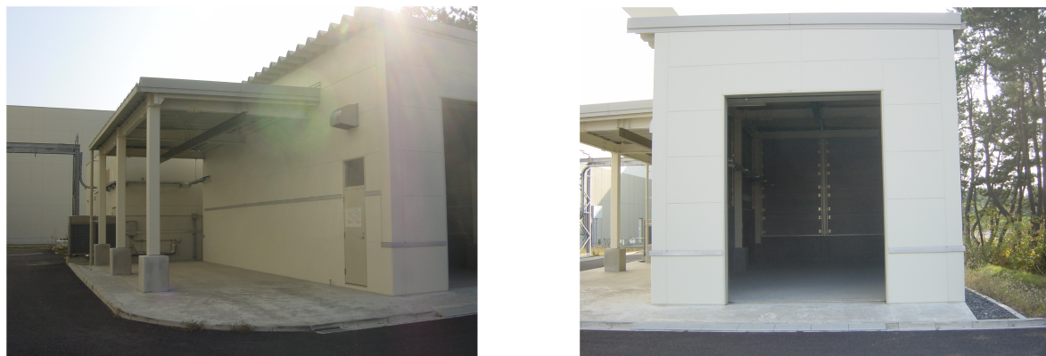
図5 ステーション建屋（写真）
