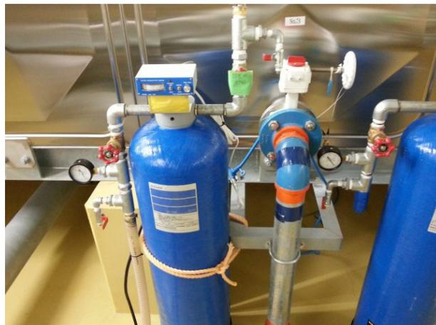
図 3: 貯留槽に設置されたイオン交換樹脂
