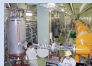
2K ヘリウム冷凍機（左）と超伝導加速空洞クライオモジュール（右）の液体ヘリウム及び液体窒素の配管接続作業
