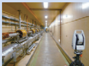
レーザートラッカーによる測定
