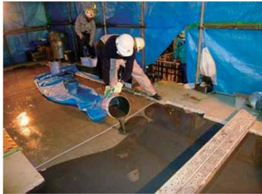
図 5 セルフレベリング床施工工事
