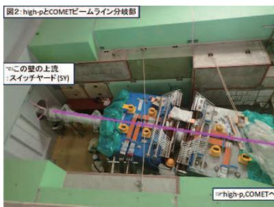
1954 年 -1958 年の間に建設された、東京大学原子核研究所(当時東京都田無市)において FM サイクロトロンとして作られ、1990 年代に、本機構つくばキャンパスで実験用に改造されて活躍した。今回、J-PARC (茨城県東海村)で再利用されることとなり、オレンジ色の円錐型磁極を追加して再設置される、歴史ある電磁石である。この電磁石は、高さ 5 m × 幅 5 m × 奥行 2 m で、総重量 340 トンになる巨大なもので、鉄ヨークの 1 ピース 5 トンから 20 トンの 24 個の主要な部品から成る。これらの部品はピース毎に精度を確認しながら組立を行い、ビームラインに対し、± 0.5mm 以内の位置精度で設置することができた。
