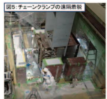
することが必要である。このため、遠隔で、できるだけ遮蔽体の陰から短時間で作業できるよう、セミリモートクランプや各種治具、遠隔操作により着脱できる吊り具を開発し、それをを用いたモックアップ試験を積み重ねた。ハドロン実験
