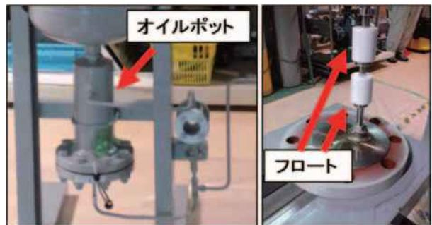
図3：2次オイルセパレータオイルポット及びオイルポット内液位検出用フロート
