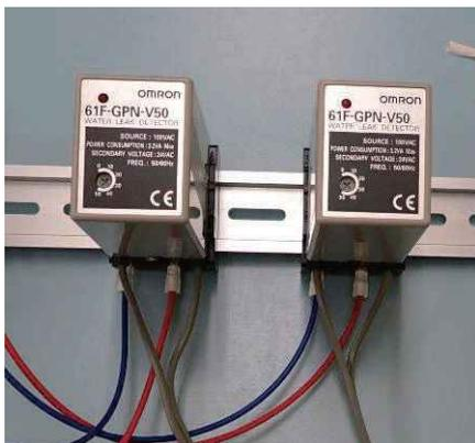
図 3：漏水検知器 61F-GPN-V50
