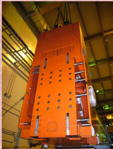
遠隔操作による電磁石の設置
