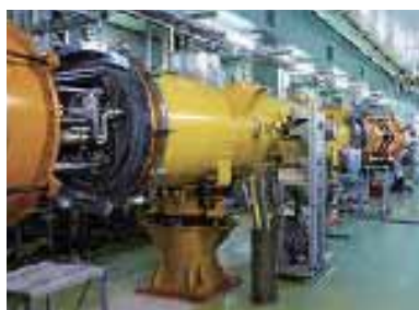
建設中のSTF
