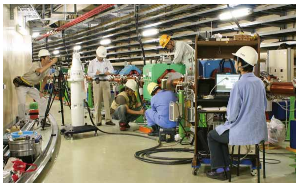
0.1mm の精度で設置される電磁石のための測定の様子
