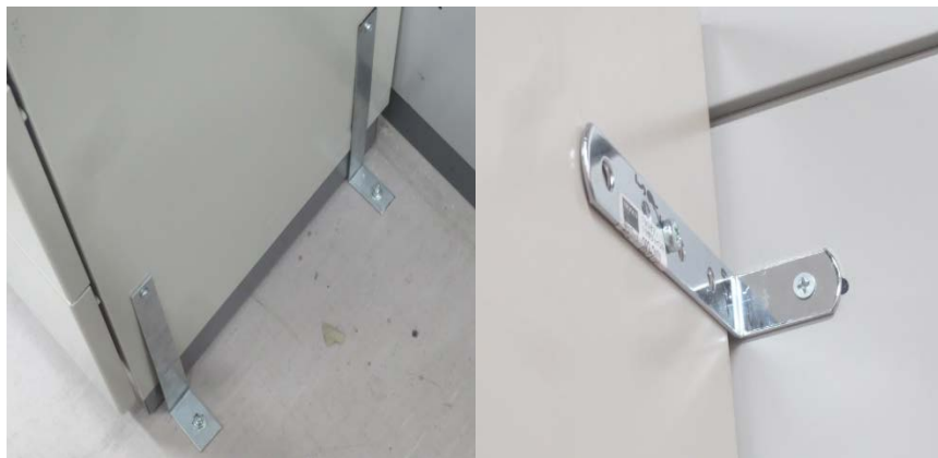
耐震固定施工例
