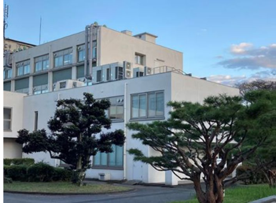
外から見た技術部室
