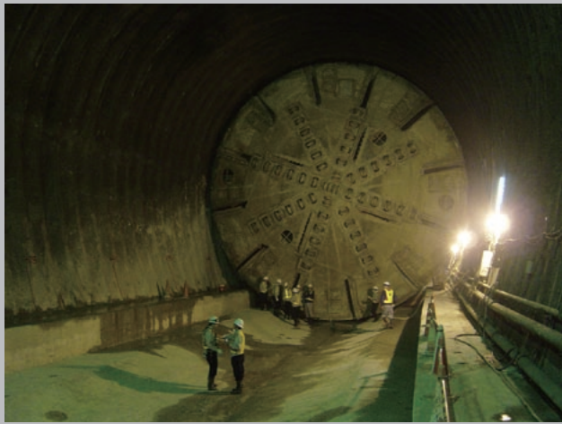
鉄道のトンネル工事で使われた TBM
