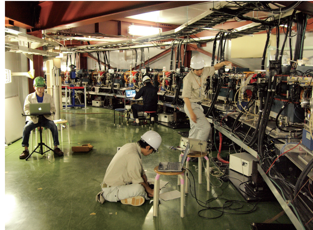
ATF加速器トンネル中で電磁石などの位置測定・調整作業が進められている。
