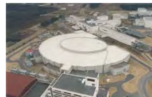
1990年 太陽熱による建物のひずみがビーム軌道の安定性に悪影響を及ぼすことがわかり、光源棟屋根の断熱化を行った。このことは、これ以降に建設された世界の放射光施設の設計に大きな影響を与えた。
