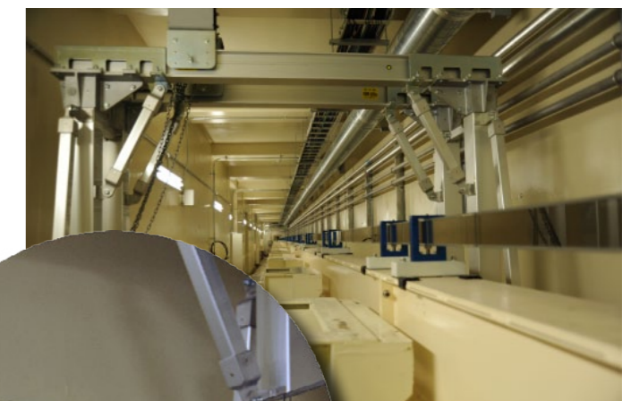
ビームライン下流から上流を臨む (上) と破損箇所 (左) 中性子を反射しながら輸送するミラーは、ガラス基板にニッケルとチタンを何層にも重ねて作られる。このミラーの筒が、中性子を輸送するガイド管。
