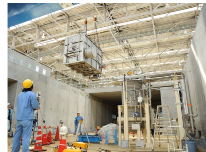
入射器用クライオモジュール設置作業の様子
