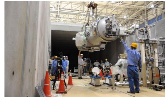
主加速部超伝導空洞の設置作業の様子
