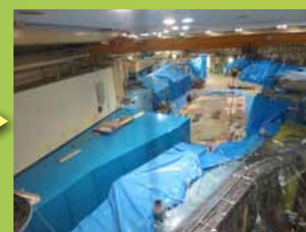
図 1d 2013 年 3 月 18 日。旧 BL-15 は全て撤去され、新 BL-15 用のメインハッチが新しく建設された。実験装置が設置される場所の周辺は床工事の準備がされている。
