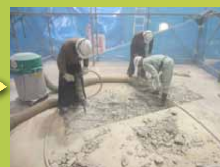
図 1e 2013 年 3 月 19 日。床工事が始まる。
