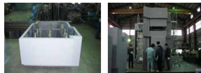
POLANO のコンクリート遮蔽体の製作状況
