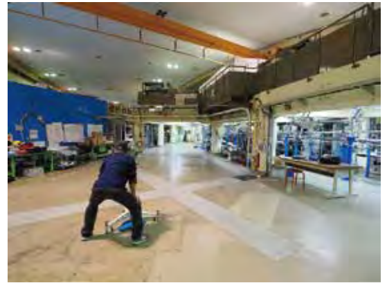
開発研究多機能ビームライン建設予定地の測量の様子(2023年8月)。旧BL-11A, B, Dの撤去が完了し、装置の一部は建設中のBL-12Aに移設される。
