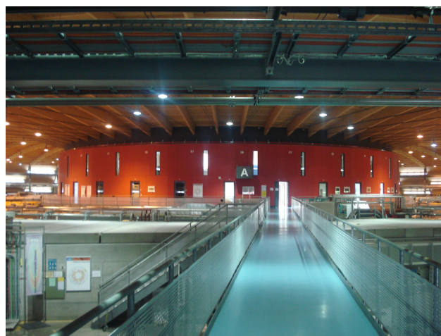
図1 SLS内部。中央の筒は内部スタッフ居住棟。手前のコンクリート壁の中にストレージリングがある。
