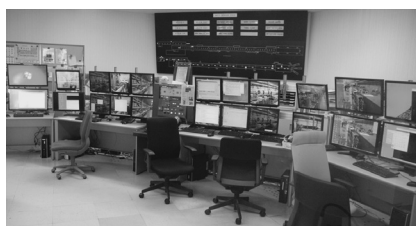
図 2 30 年ぶりに更新された入射器制御卓。複雑化した入射ビームの制御への対応が容易になった。
