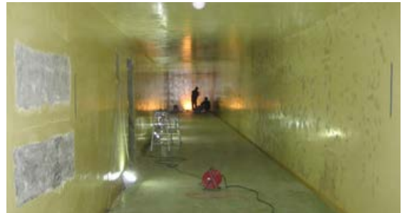
図4 上図は昨年11月頃のトンネル躯体を掘っている工事現場、 下図はトンネルの塗装前の写真。
