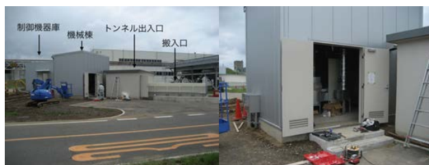
図 4 新トンネル地上部 (左図) および機械棟内部 (右図) の様子。
