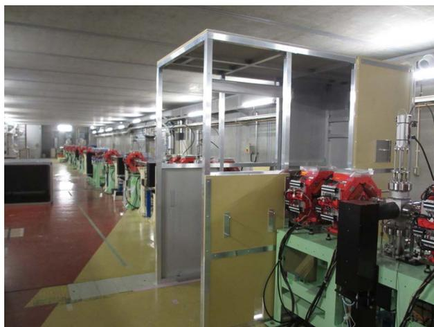
図2 恒温壁が建設された加速器室内の様子(11月)。
