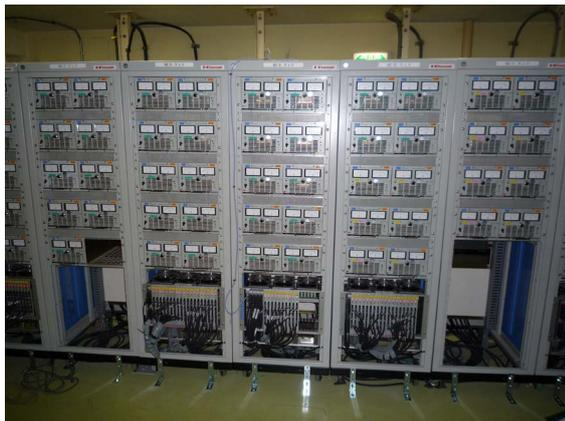
図2 PFリングの小型電磁石電源とその制御系の一部。
