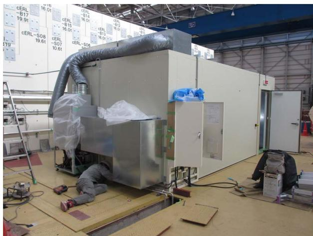
図1 加速器室外に設置される大強度CWレーザーを設置するレーザーハットの建設の様子。
