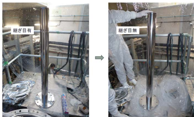
図1 接続したカソードロッドと新規製作した一体のカソードロッド。
