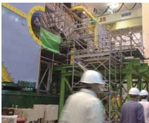
図3 施設変更の申請箇所において、複数の観点から検査が行われた。
