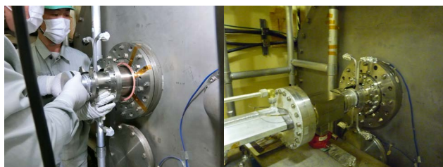
図1 超伝導ウィグラーに更新用の真空ビームダクトを接続(左図)し、溶接を行って下流のビームダクトを復旧(右図)した様子を示す。
