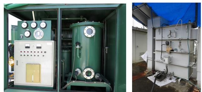
図4 新油注入のためのタンクローリー(上)、真空脱気装置、発電機の配置(下左)、真空脱気装置(下右)。
