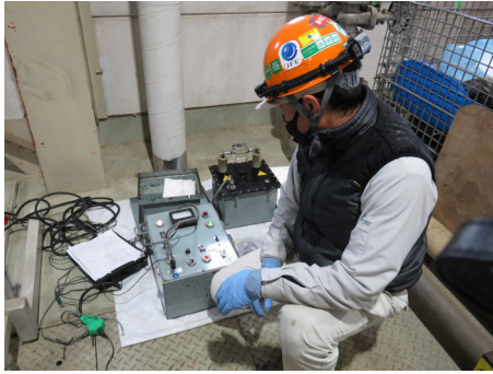
図5 絶縁耐圧試験機によるサンプリング検査
