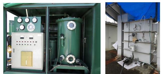
図4 新油注入のためのタンクローリー(上)、真空脱気装置、発電機の配置(下左)、真空脱気装置(下右)。
