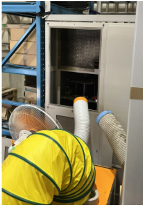
図2 IGBTのファン故障のため、加熱インターロックで停止した四極電磁石電源。一時対処として、外部より強制空冷することで運転を継続した。その後、粉塵の侵入対策としてフィルターを設置するなどの対処を実施した。
