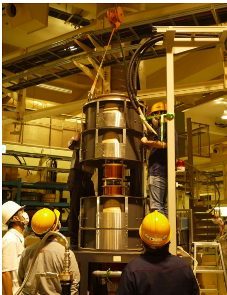
図4 クライストロン交換作業
