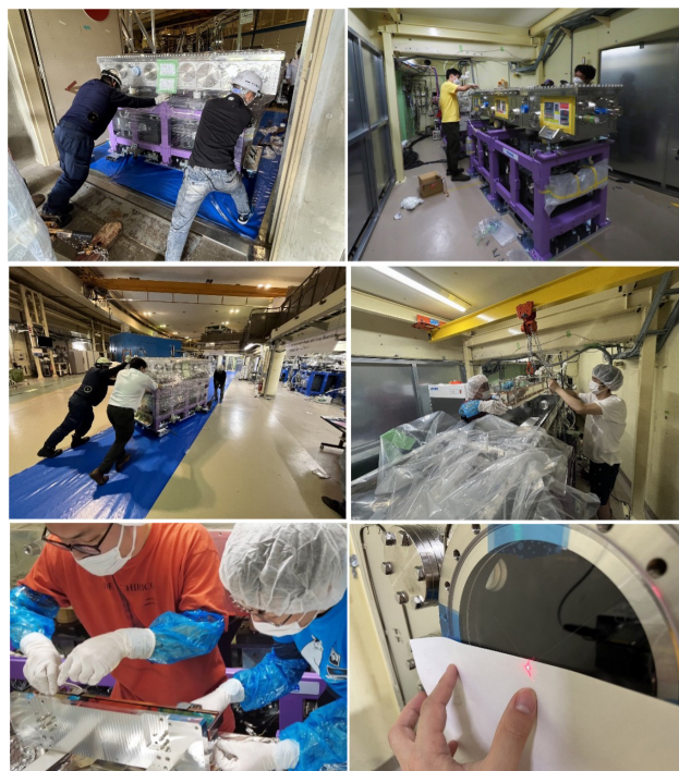
図1 BL-11大型ミラーチャンバー設置の様子
