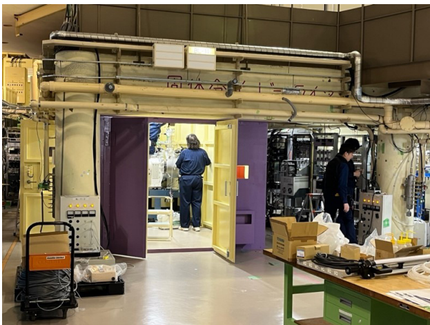
図1 1/23時点のBL-11建設作業の様子(完成した光学ハッチとハッチ内に設置されたR&D用二結晶分光器が見える)。
