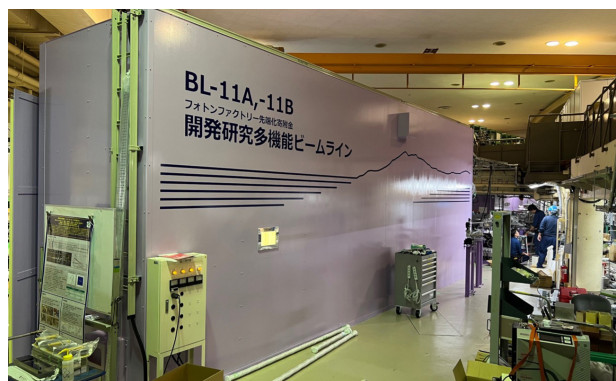
図 1 8/18 現在の BL-11 建設作業の様子 (巨大な実験ハッチが完成)
