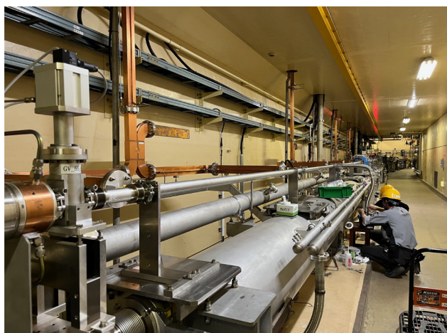
図3 KL56 RFユニット加速管撤去後の真空配管作業の様子
