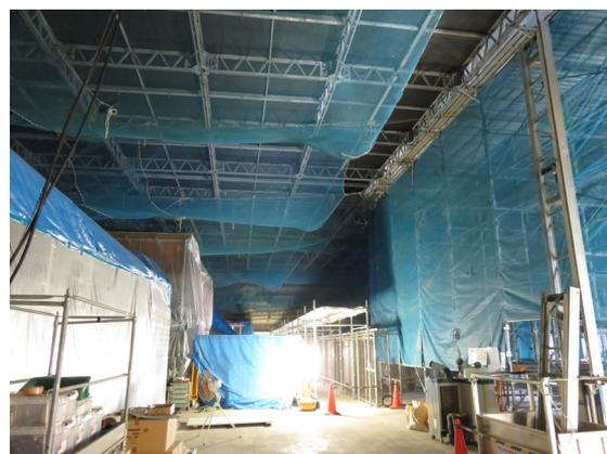
図3 PF 電源棟天井改修工事の様子
