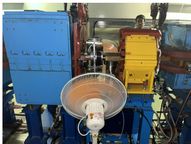
図6 NW9 ダクトの強制空冷
